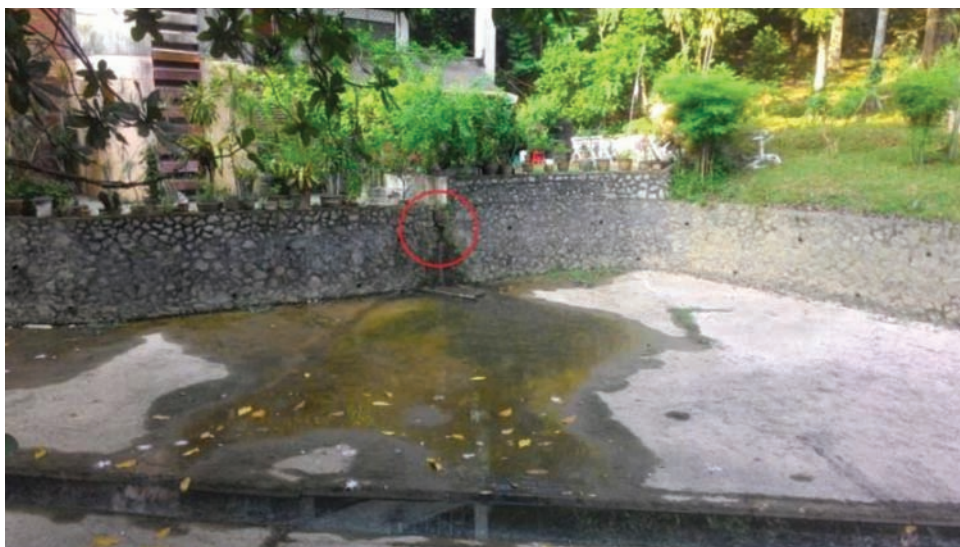
RAJAH 4. Lokasi pelepasan air daripada kafeteria, lokasi persampelan D
