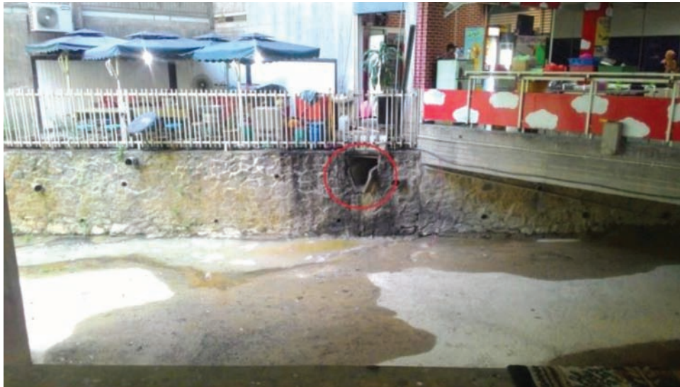
RAJAH 3. Lokasi pelepasan air daripada kafeteria, lokasi persampelan C
