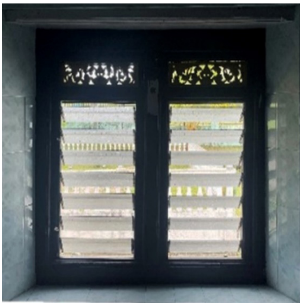
RAJAH 8. Tingkap ram kaca boleh laras dua panel (lama) pada Masjid Lama Linggi
