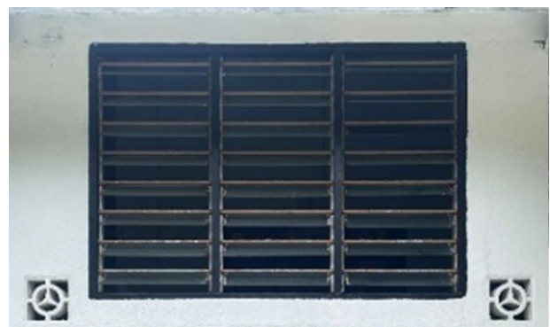
RAJAH 10. Tingkap ram kaca boleh laras tiga panel (baru) pada Masjid Lama Linggi
