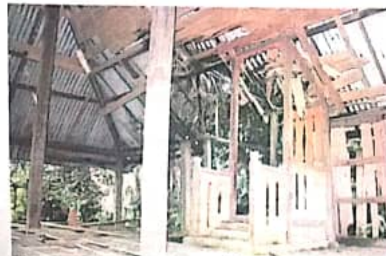
Tiang gantung di tengah bumbung masjid melambangkan lima rukun Islam.
