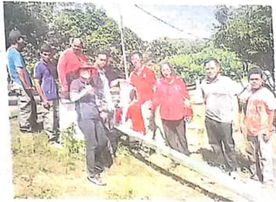
KERJA pemasangan lampu jalan panel solar turut dibantu masyarakat Orang Asli
