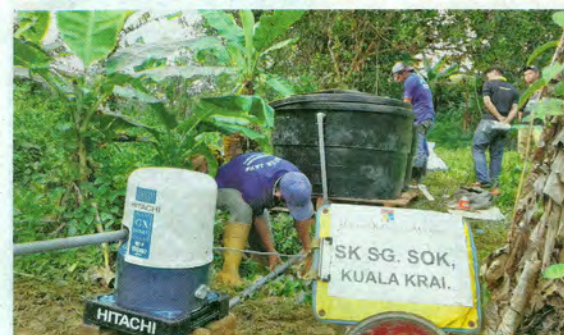
KERJA-KERJA pembinaan sistem telaga tiub oleh kontraktor yang terlibat.
