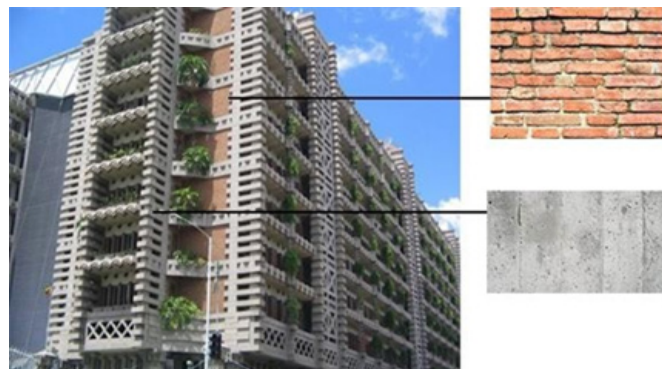
RAJAH 8. Penggunaan bahan tanah liat dan konkrit untuk mengurangkan haba masuk ke dalam bangunan (Costesia 2013)
