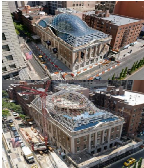
RAJAH 3. Reka bentuk kubah yang terdapat pada bangunan Dewan Tammany mengambil sistem dan rupa bentuk daripada cengkerang kura-kura (Kim et al. 2018).
