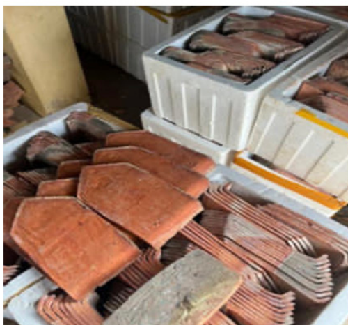
RAJAH 5. menunjukkan perbezaan di antara atap singgora baharu (a) dengan atap singgora terpakai (b)
