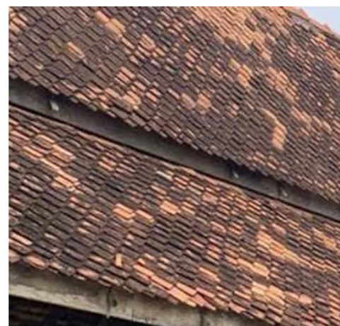
RAJAH 5. menunjukkan perbezaan di antara atap singgora baharu (a) dengan atap singgora terpakai (b)
