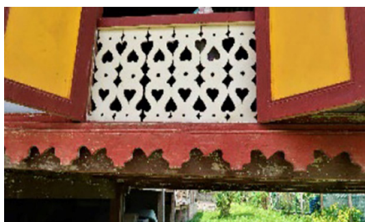
RAJAH 3. Reka bentuk kisi-kisi atau lubang angin pada fasad Rumah Tradisional Melayu Sumber: (Ahmad 2025)
