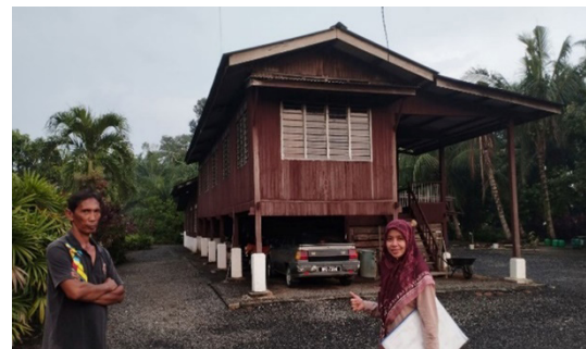
RAJAH 8. Keadaan semasa Rumah Kampung Tanah Raja, Banting, Selangor (RTR)
